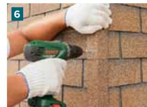
**6** Внешние углы дома закройте внешними металлическими уголками при помощи окрашенных оцинкованных саморезов по металлу с шагом 30 см.
