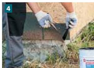
**4** Части плитки, выходящие на внешние и внутренние углы дома, промажьте клеем-адгезивом на ширину 10 см.
